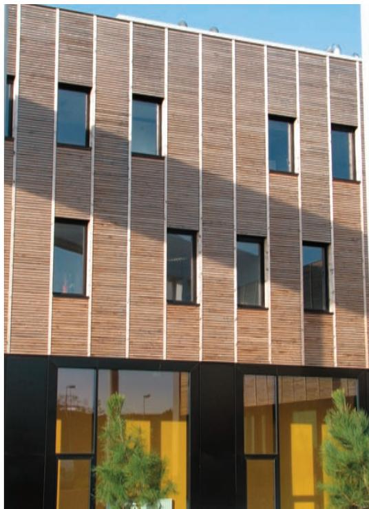
Les différences énergétiques induites par les expositions du bâtiment ont été prises en compte. Ainsi, l'existence de brises soleil et d'une isolation extérieure en bois permet de stabiliser les températures dans les locaux.
