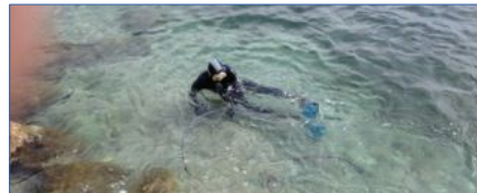
Raccordement de l'ombilical dans le regard du-ponton
