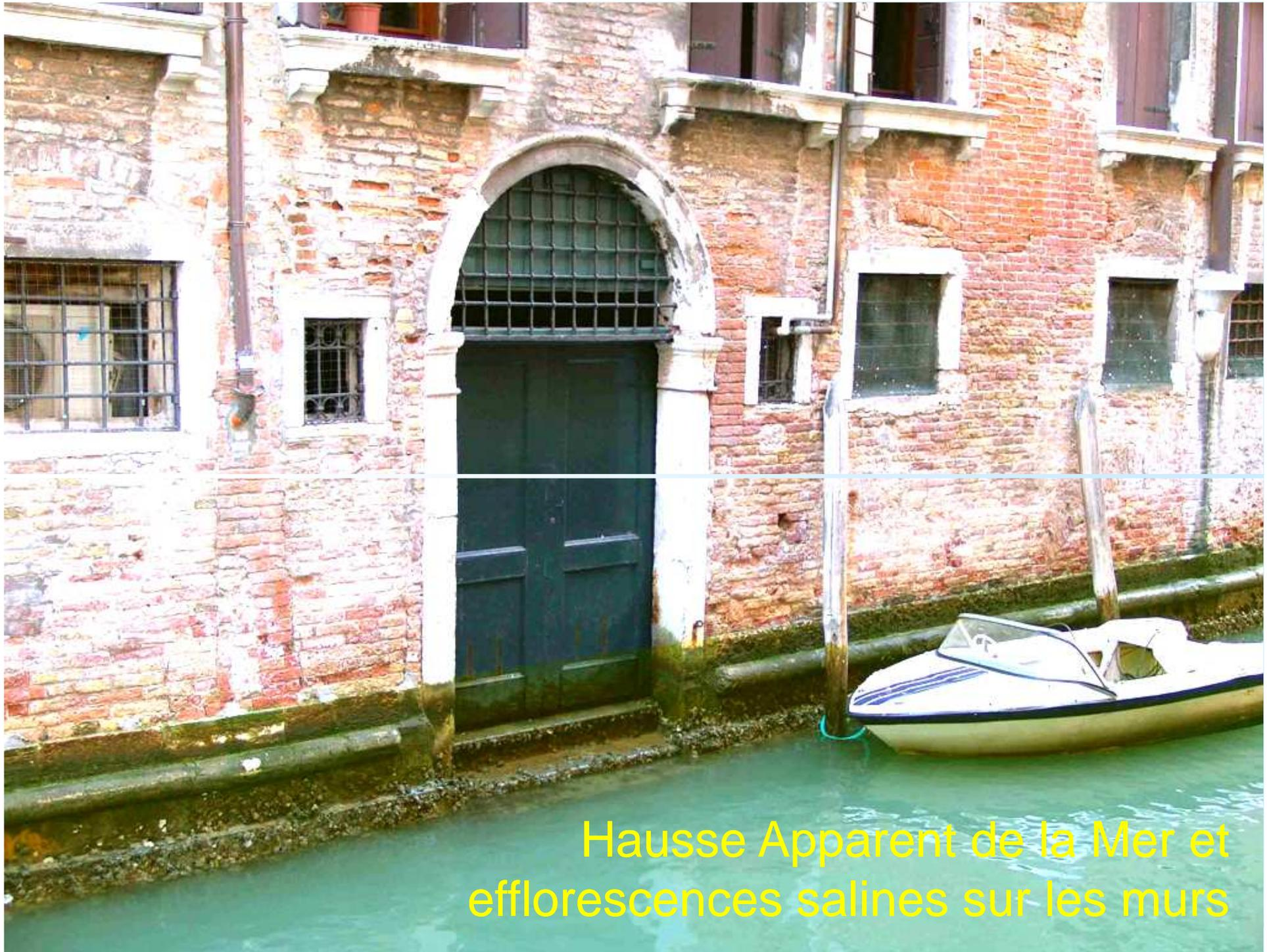
Hausse Apparent de la Mer et efflorescences salines sur les murs
